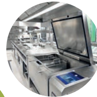
hochmoderner Umbau der Küche
